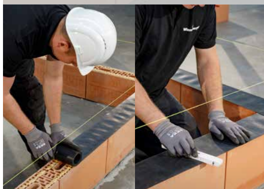
11. De waterkering plaatsen en goed vlak aandrukken op de aangebrachte Dryfix extra
