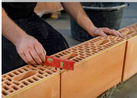
6. De vlakke verbinding tand en groef controleren
