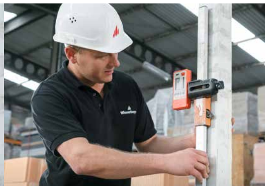
2. De vloerpas uitzetten
