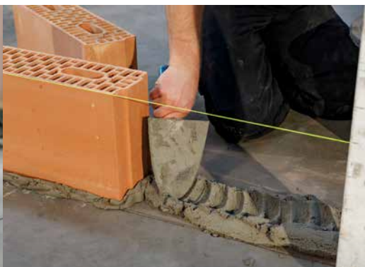
4. De eerste laag (kimlaag) uitmetselen met traditionele mortel
