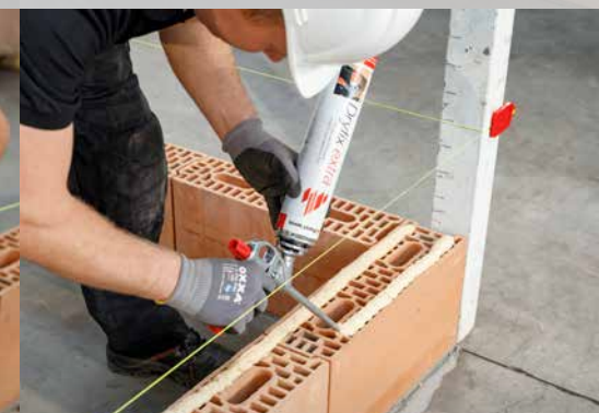
10. Dryfix extra aanbrengen in 2 stroken van 3 cm breed en op \pm 1 cm van de buitenzijde van de steen*
