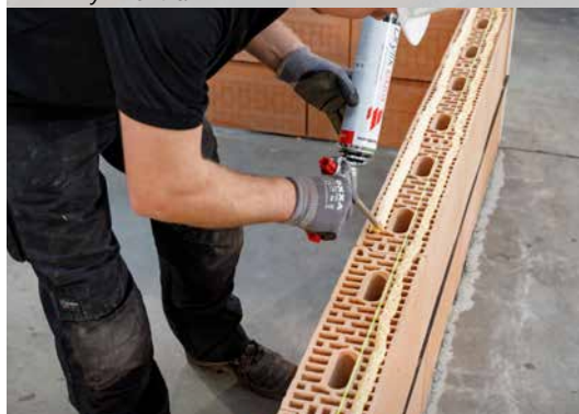
16. Dryfix extra aanbrengen in 2 stroken van 3 cm breed en op \pm 1 cm van de buitenzijde van de steen
