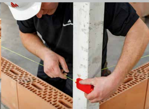
9. De metselkoord aanbrengen op hoogte \pm 2 cm onder de hoogte van de tweede laag
