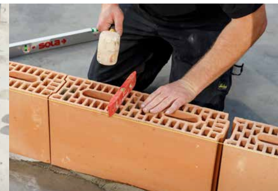
5. De vlakheid dwars op de muur controleren
