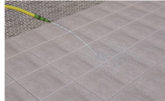
Besproeien met water alvorens te reinigen
