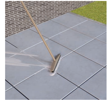
Voegen met voegmortel en voegrubber
