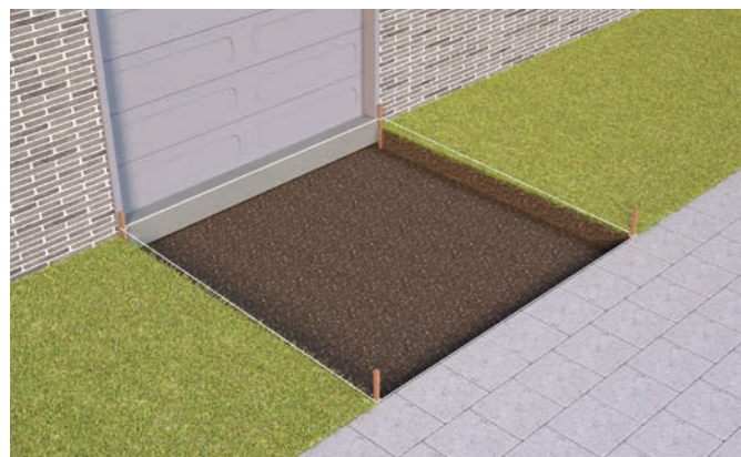
Uitzetten met piketten en niveau bepalen
