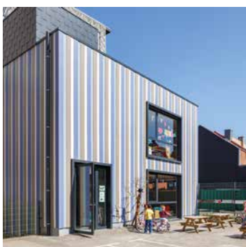
Speelse uitbouw met verticale plaatsing
