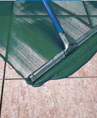
Op de vloer aanbrengen van Ultracolor Plus met een trekker
