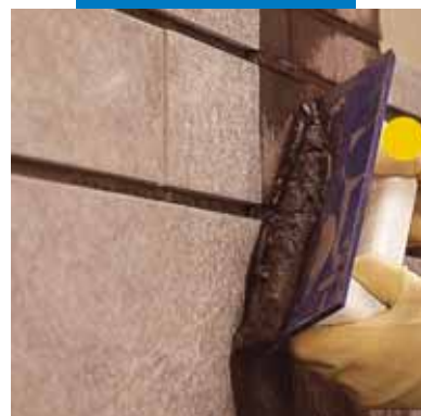
Op de vloer aanbrengen van Ultracolor Plus met een voe grubber
