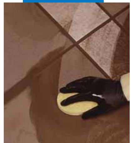
Reinigen en afwerken van voegen met een spons
